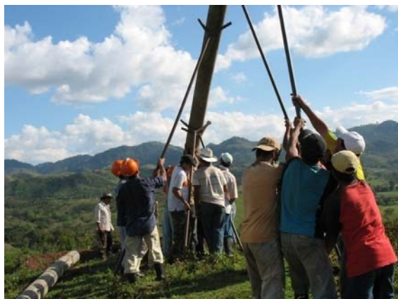
Hincado de postes
