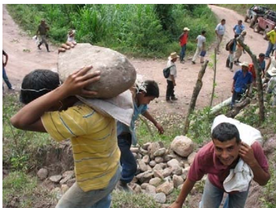
Acarreo manual de piedras de fijación
