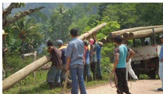
Descarga manual de los postes
