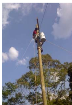
Subida de transformador
