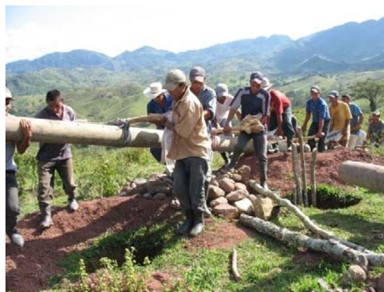
Traslado de postes hasta su ubicación
